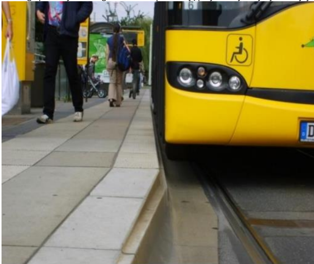
Rys. 9.11 Zalecane ukształtowanie podniesionej krawędzi peronowej
