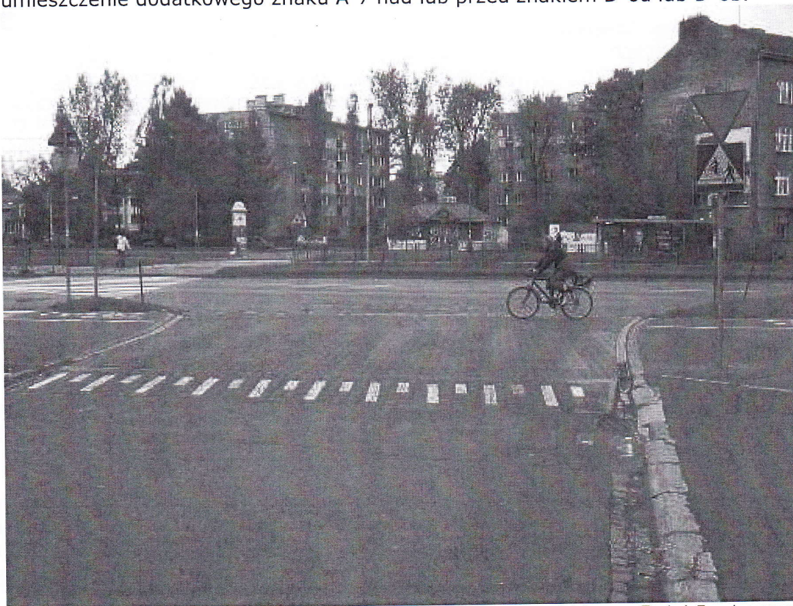
Rys. 1. Przejazd dla rowerzystów prowadzony grzbietem płytowego progu zwalniającego. Znak A-7 umieszczony jest wraz ze znakiem D-6b na wlocie podporządkowanym przed drogą dla rowerów. Próg zwalniający jest doskonałym rozwiązaniem poprawiającym bezpieczeństwo rowerzystów w tej sytuacji. Kraków, skrzyżowanie ul. Monte Cassino i Władysława Mitkowskiego.
