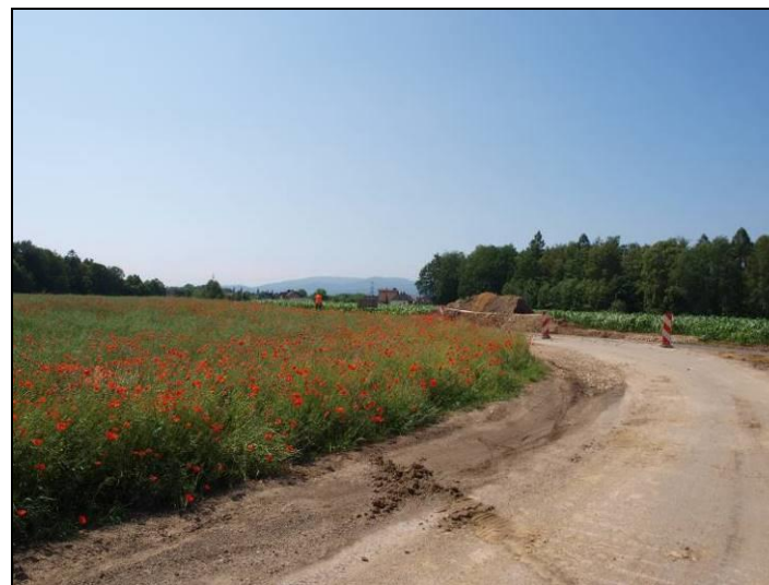
Fot. 7 Teren nr 2, przebudowywana ul. Lipowska
