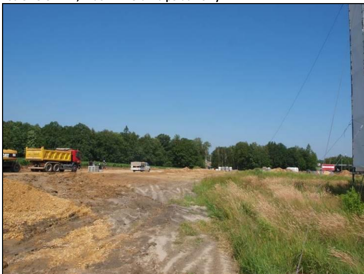
Fot. 6 Teren nr 2, powstająca nowa zabudowa w części północnej
